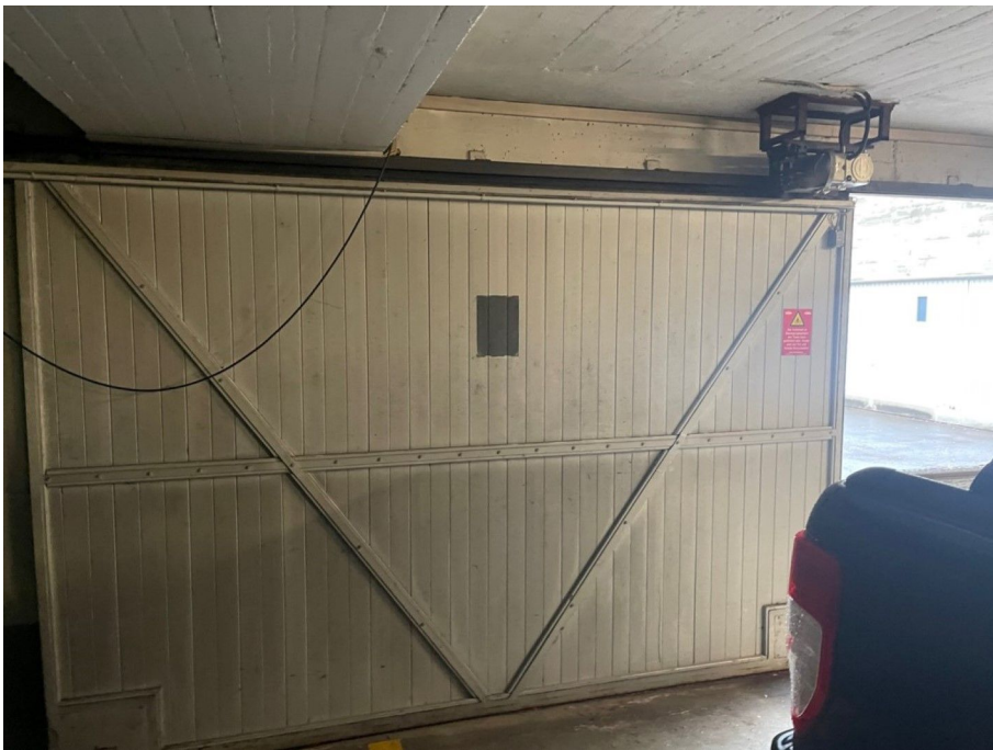
Tor vorher (Innenansicht)
